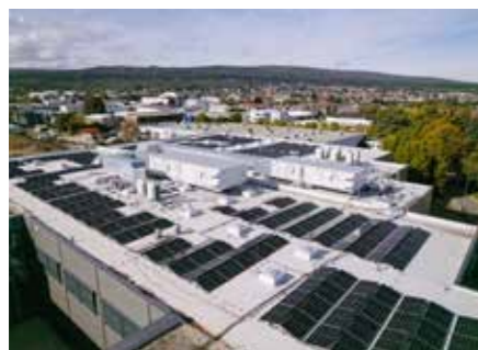
屋上にはソーラーパネルを設置
